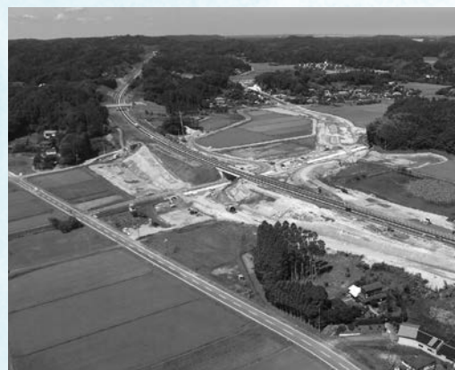
(仮称) 茂原長柄スマートインターチェンジ工事現場航空写真
