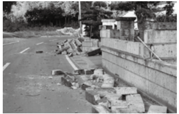
千葉県東方沖地震(昭和62年)による災害
