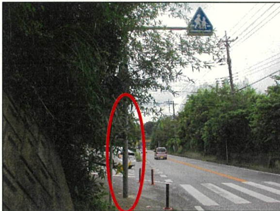
⑤ 【対策後】 注意喚起看板設置 【対策後】
