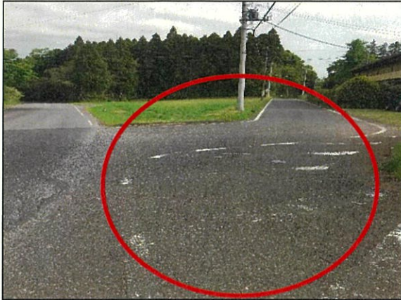
③ 【対策前】 区画線の引き直し等 【対策後】
