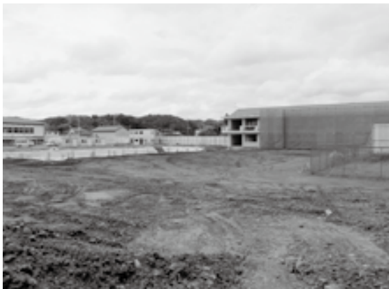
基礎コンクリート打設 平成21年7月24日撮影
