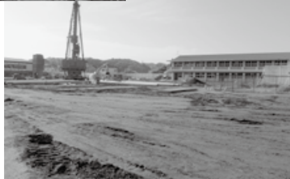
基礎くい打ち 平成21年6月28日撮影
