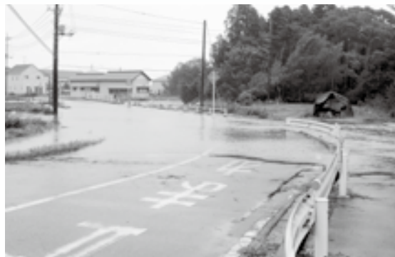
平成25年10月 台風26号による道路冠水
