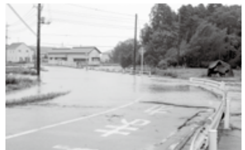
平成25年10月 台風26号による道路冠水
