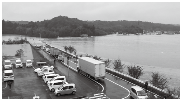
氾濫した一宮川（役場屋上から撮影）
