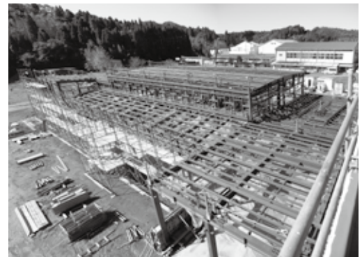
鉄骨組み上げ中
