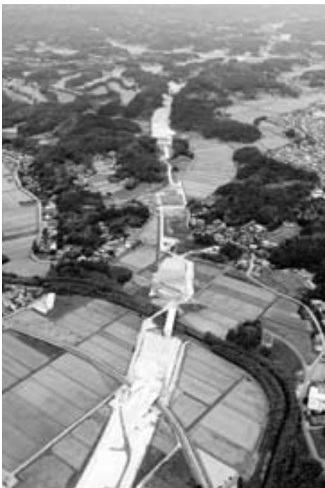
長南町岩川付近上空から長柄町区間を撮影 資料提供：NEXCO東日本
