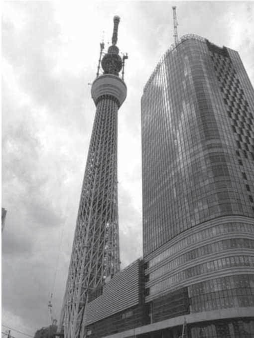
▲建設中の東京スカイツリー
