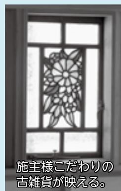
山根の建築現場。古雑貨屋になります。
